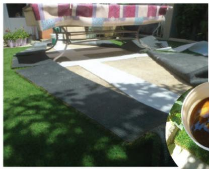
Ouvrir le pot de colle et verser entièrement le bidon du durcisseur, malaxer l'ensemble (1 pot de 11kg = 25m de bande de jonction). Retourner le gazon au niveau du joint sur 40 cm afin de positionner la bande de jonction (côté cartonné sur le sable et le côté fibré au dessus)
