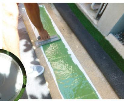
Une fois la colle malaxée, remettre le bouchon du pot en le découpant sur le dessus pour réaliser un bec verseur afin de faciliter l'écoulement. Faire couler la colle sur la bande à l'aide d'une spatule de carreleur.
