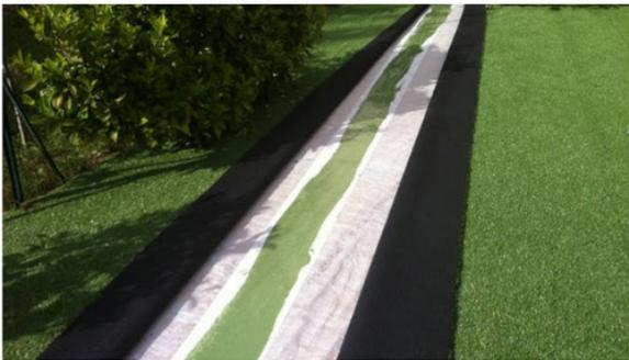
Ouvrir le pot de colle et verser entièrement le bidon du durcisseur et malaxer. Couler la colle sur la bande et étaler à l'aide d'une spatule de carreleur
