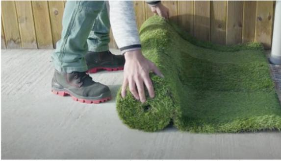
Placer les rouleaux côte à côte et dans le même sens de fibre
