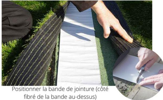
Positionner la bande de jointure (côté fibré de la bande au-dessus)
